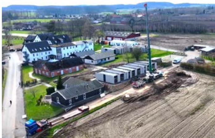
Dronefoto af den nye efterskoleafdeling under opførelse. (Dronefotograf: Christian Hornslet Bjørkvig, april 2024)
