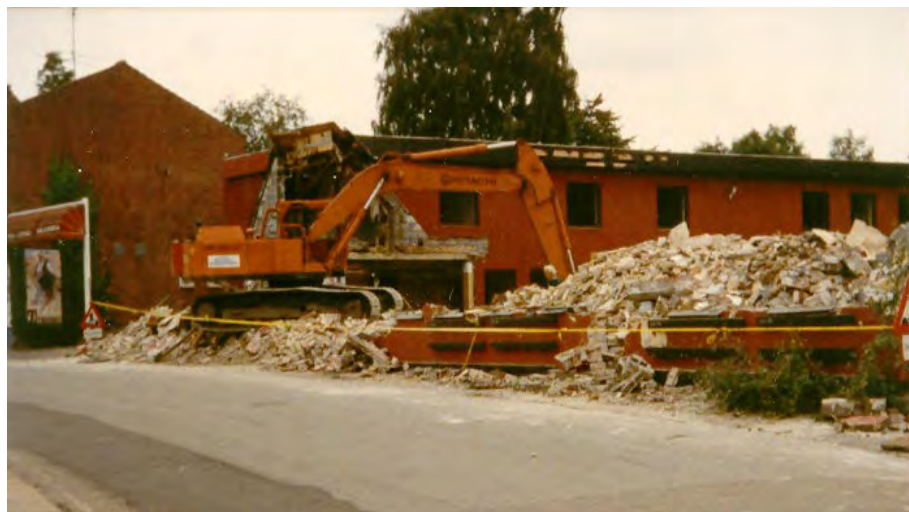
Byggefirmaet Jørgen Jensen i gang med nedrivningen af kroen. (1990 - LAS)
