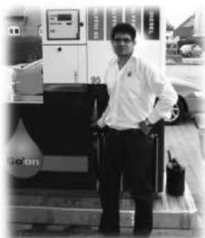
Inam foran det flotte nye tankanlæg, ventende på receptions gæster
