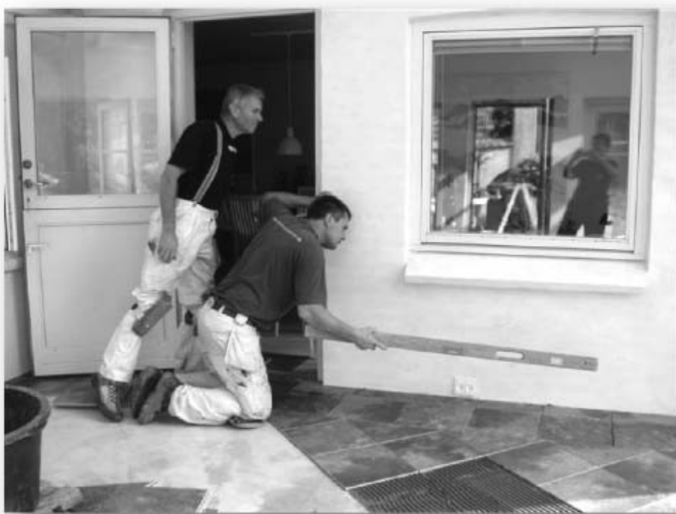
Far og søn i gang med fliselægningsarbejde.
