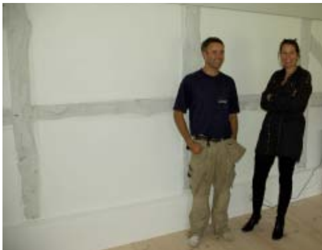
Stolperne fra det gamle bindingsværk med mærker efter hestebid er bevaret som en del af værelsernes udsmykning
