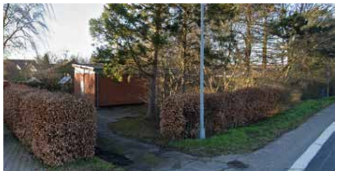
Den fuldt automatiserede telefoncentral på Nyborgvej. (foto; Google Maps marts 2023)
