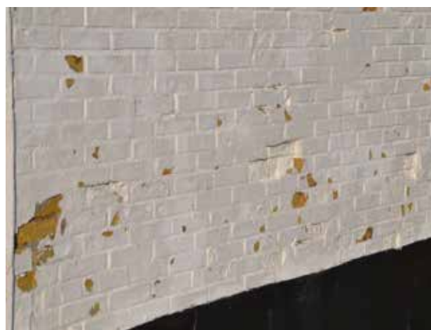
Skader på facaden – ser ikke godt ud.
